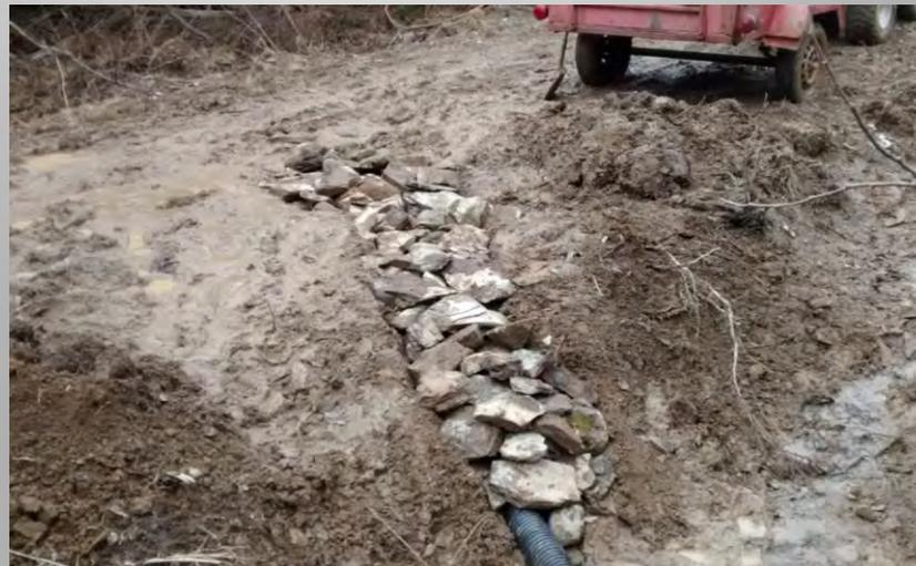
2. Remplir au 2/3 de roches ou de billots de cèdre. Possibilité d'y mettre un drain.
