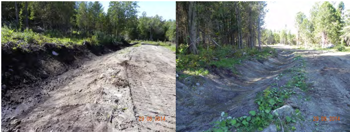
Figure 21 : Mise en forme préliminaire des talus
