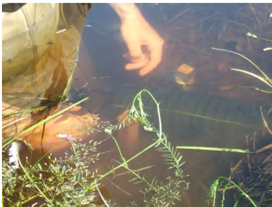
Figure 7 : Installation drain, étang amont, juil. 2014
