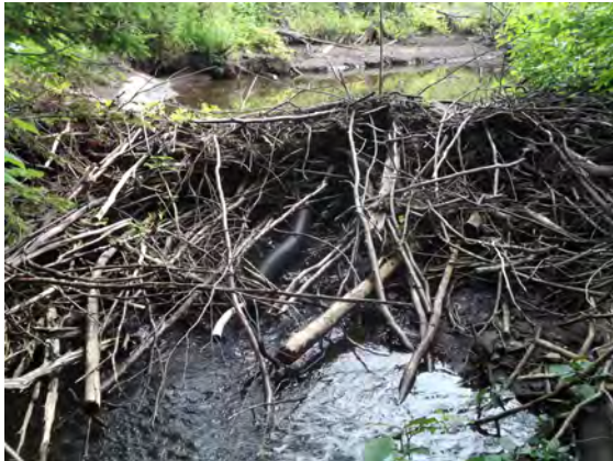
Figure 11 : Suivi drain 24 juillet 2014
