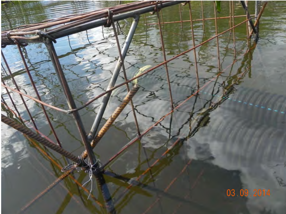
Figure 18 : Arêtes en métal et solidification des coins
