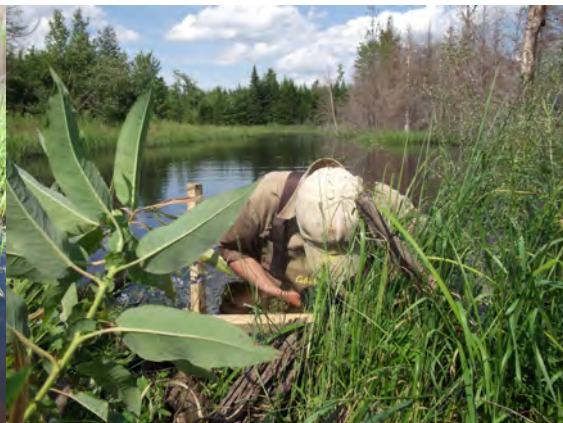
Figure 6 : Installation drain, étang amont, juil. 2014
