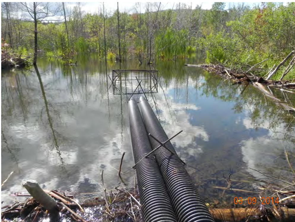
Figure 19 : Utilisation de ponceaux de plastique (6 pouces de diamètre)
