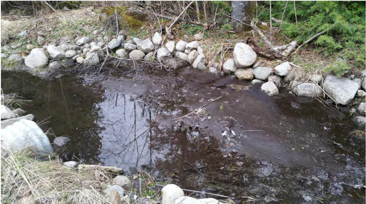
*Figure 3.5: Bassin de sédimentation ayant besoin d'être vidangé du Chemin du Lac-des-Trois-Milles Sud en 2017*
