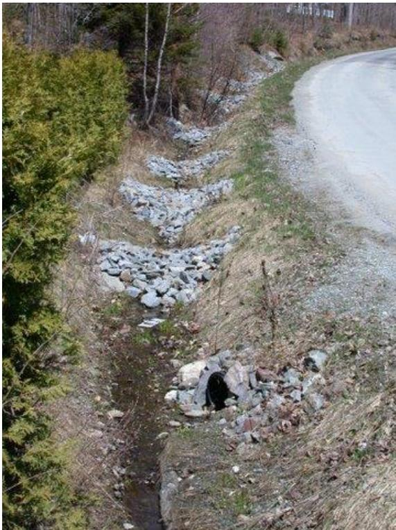
Figure 3.4: Photo d'un réseau de seuils de rétention dans un fossé routier (Le Rappel, s.d.)
