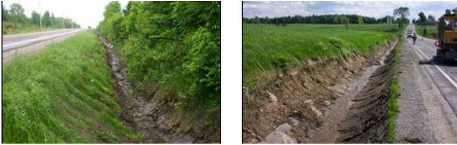
Figure 3.1: Méthode d'entretien par le tiers inférieur (à gauche) versus la méthode traditionnelle (à droite). (Monast Robineau et al, 2006)
