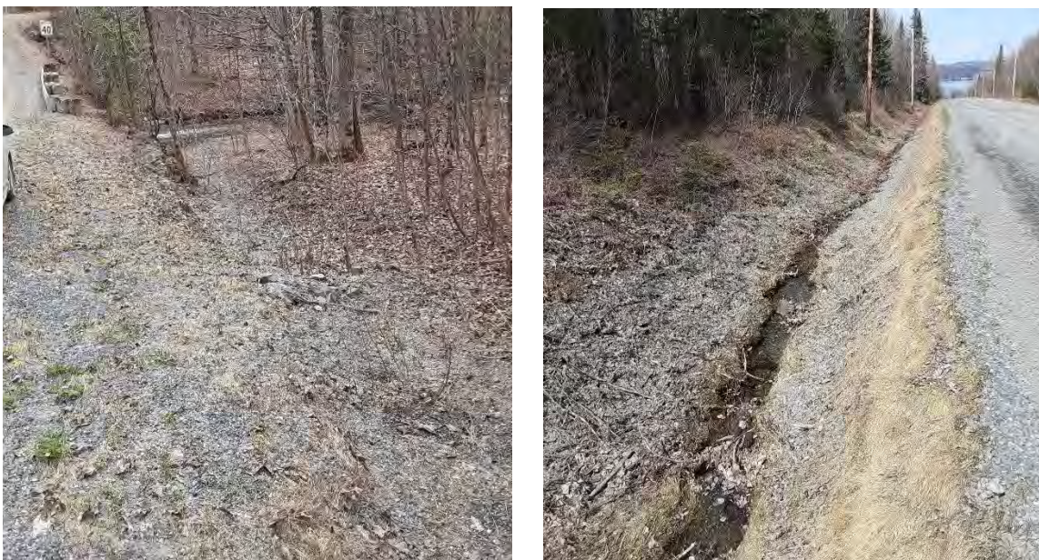
Figure 1. Accumulation de sédiments provenant des opérations de déneigements
