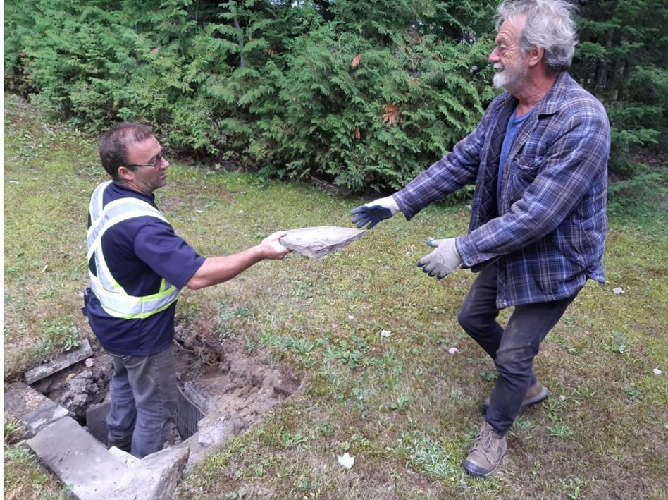
*Figure 6: Dégagement des pierres au-dessus du drain*
