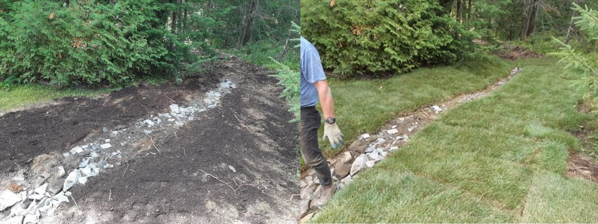
*Figure 11: Étalement de compost et de rouleaux de gazon*
