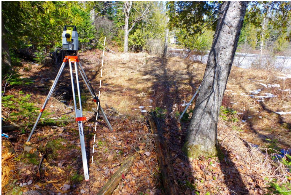
Photo 5 Vue sur le terrain en aval des remblais actuels. La ligne en tiret montre approximativement l'axe de la digue projetée.
