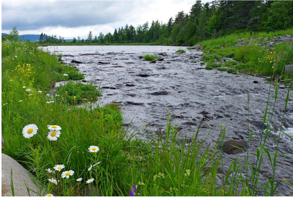
Photo 6 Barrage du lac Drolet. Une structure en bois a été remplacée par une structure en enrochement.
